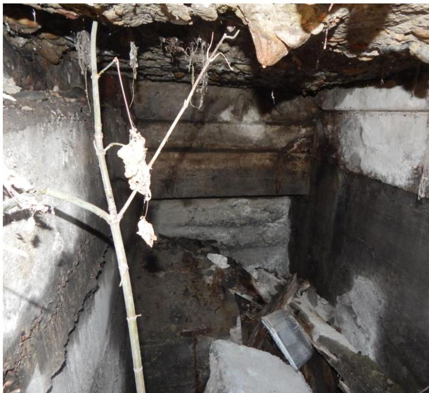
*Рисунок 8. Фото вскрытого незасыпанного вентиляционного канала*
