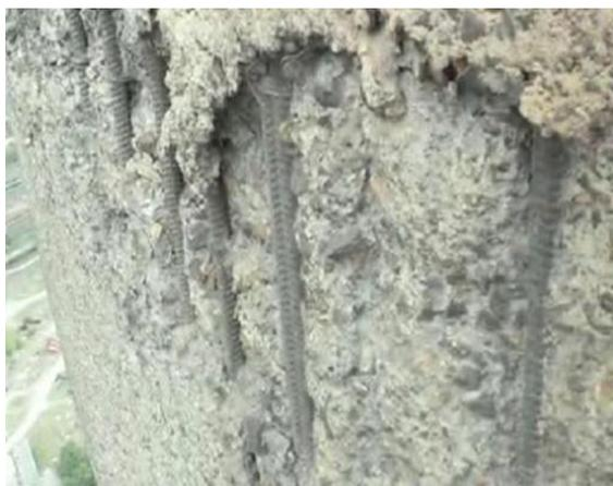
Рисунок 1. Расструктурирование бетона, оголение и коррозия арматуры с юго-западной стороны железобетонного ствола на отм.+219,5 м.
