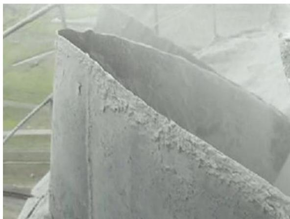
Рисунок 2. Разрушение стального оголовка газоотводящего ствола на отм. +250,0 м.
