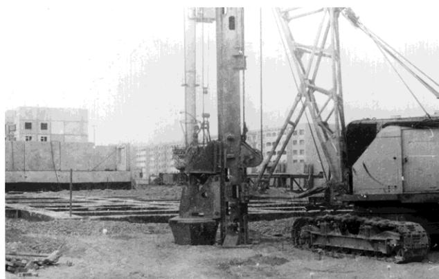
а – склад ГСМ в г. Актобе, построенный на искусственном вытрамбованном щебеночном основании с защитным экраном;
