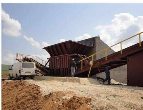
Рисунок 3. Конструкция комплекса ДСКА производительностью 600 т/час для одностадийного дробления (до фракции 0-25 мм) и сортировки лигнита в варианте поставки компании «Bitola» (Республика Македония).
