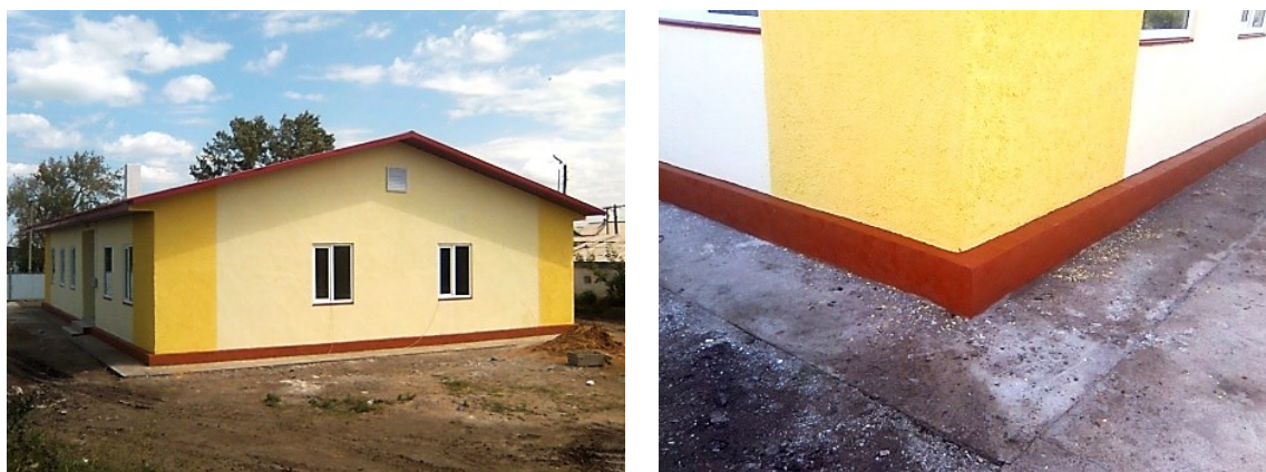
Рис. 3. Внешний вид готового дома, собранного по технологии ЛСТК
