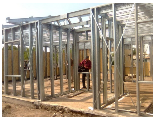
Рис. 2. Возведение каркаса по технологии ЛСТК
