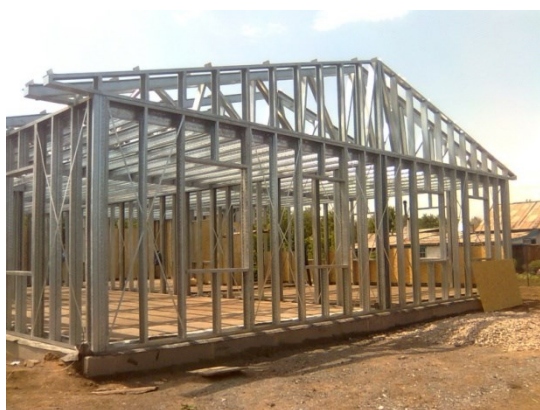
Рис. 2. Возведение каркаса по технологии ЛСТК
