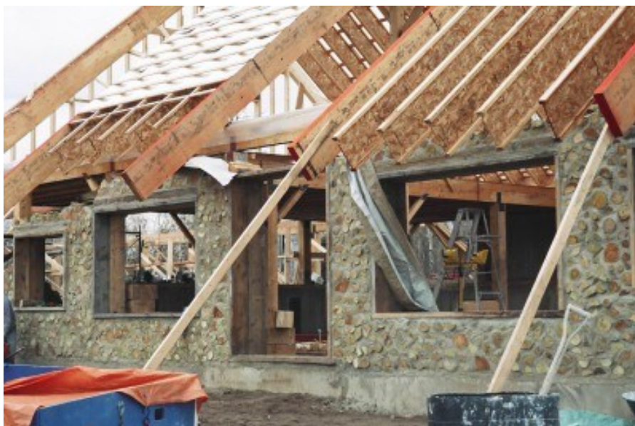
Рис. 1. Строительство глинобитного дома
